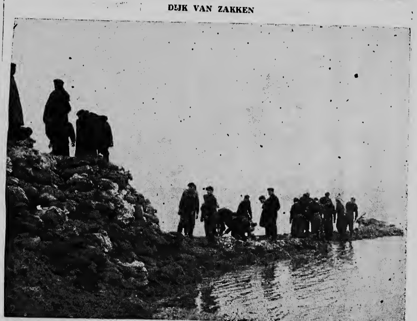
Ontelbaar zijn de zakken zand, welke de gaten in de gebroken dijken opvullen. Deze opname, welke werd gemaakt bij het Zuid-Bevelindse plaatsje Rilland-Bath, geeft een goed beeld van de immense hoeveelheid zakken zand, welke daar met de hand gestapeld zijn en nog worden, door de soldaten van de 41ste afd. Veldartillerie. (Foto ANP)
